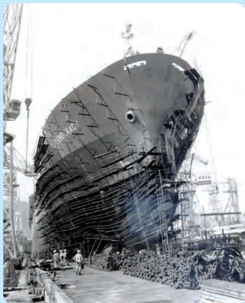
造船中の様子。 ブロックごとに作ったパーツを つなぎ合わせたところだよ。
