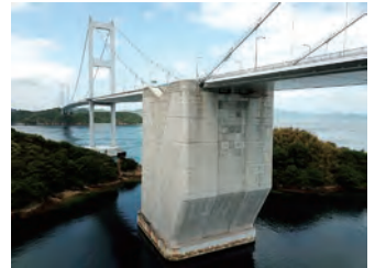
因島側から見た、因島大橋のアンカレイジ
