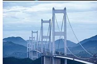
来島海峡第一大橋 … 形式：3径間2ヒンジ補剛箱桁吊橋
