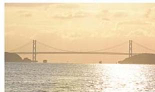
形式：3径間2ヒンジ補剛トラス吊橋
