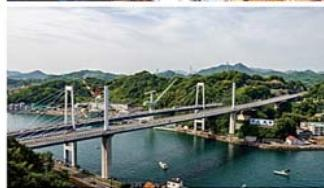
形式：5径間連続鋼箱桁斜張橋
